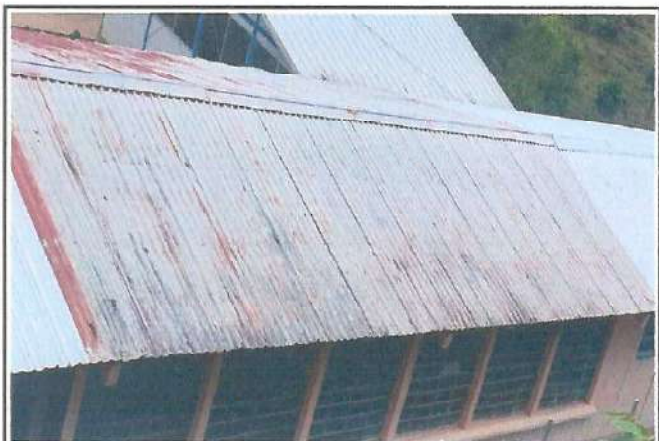
Foto 3: MEJORAMIENTO DE ESTRUCTURA DE TECHO
