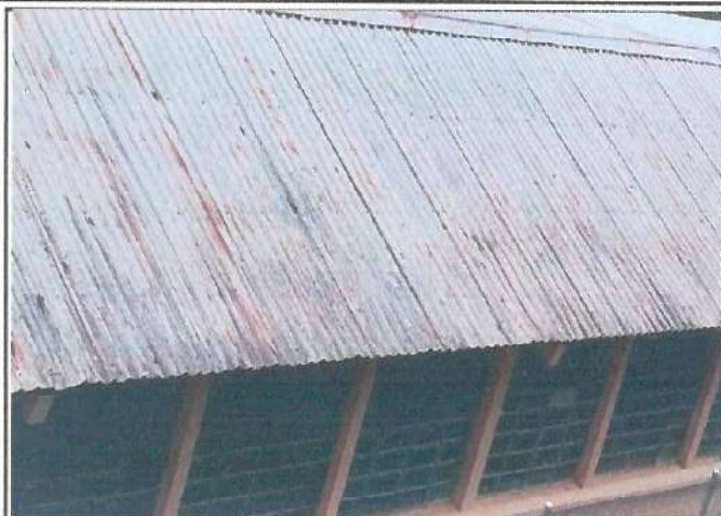
Foto 1: 1. MEJORAMIENTO DE ESTRUCTURA DE TECHO
