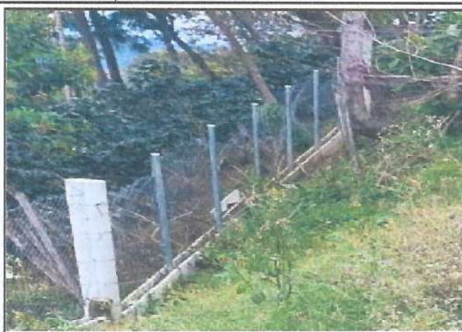
Foto 2: MEJORAMIENTO DE CERCO O MURO PERIMETRAL
